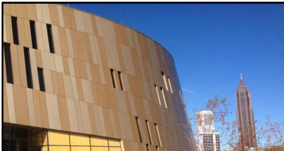
**Figura 5 - Fachada curva executada com placa laminadas (Ref. Trespá)**
